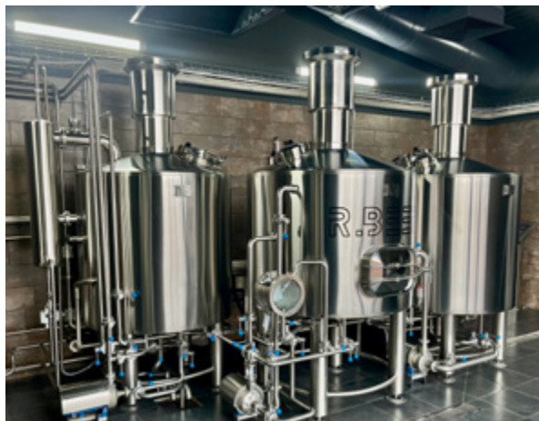
Riverwood с. Мошни, Черкаська обл. Трьохпосудний варочний порядок об'ємом 500л/варка з півавтоматичним керуванням. Складається із заторного, фільтр-чана та сусловарочного віртюла. Для автоматизації використовується автоматика від Siemens. Укомплектовано ЦКТ 1000L
